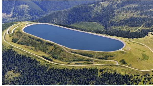
Vodní elektrárna Dlouhé Stráně
