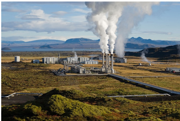
Island - geotermální elektrárna
