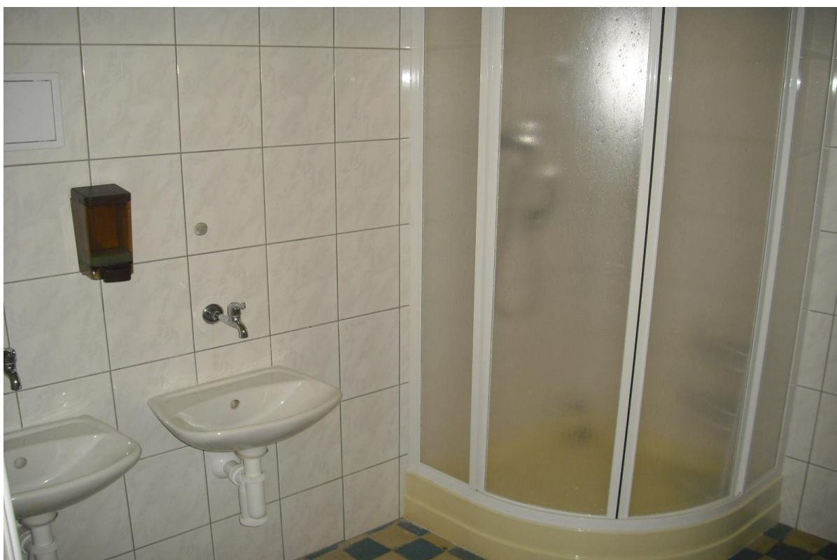
Částečná rekonstrukce sociálního zařízení oddělení Sluníček
