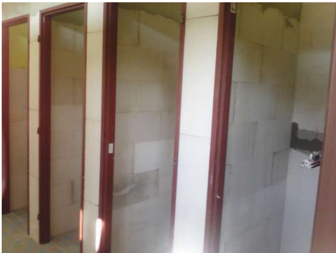
Modernizace dívčího sociálního zařízení
