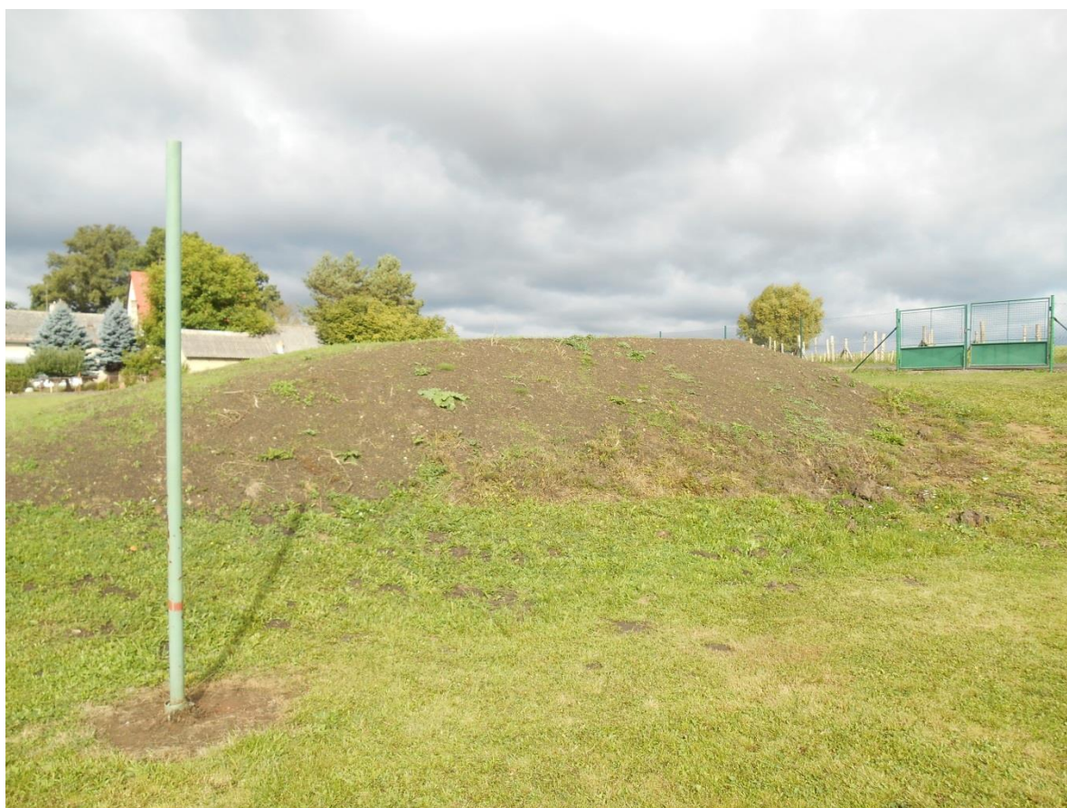
Vybudování „kopečku“ pro sáňkování
