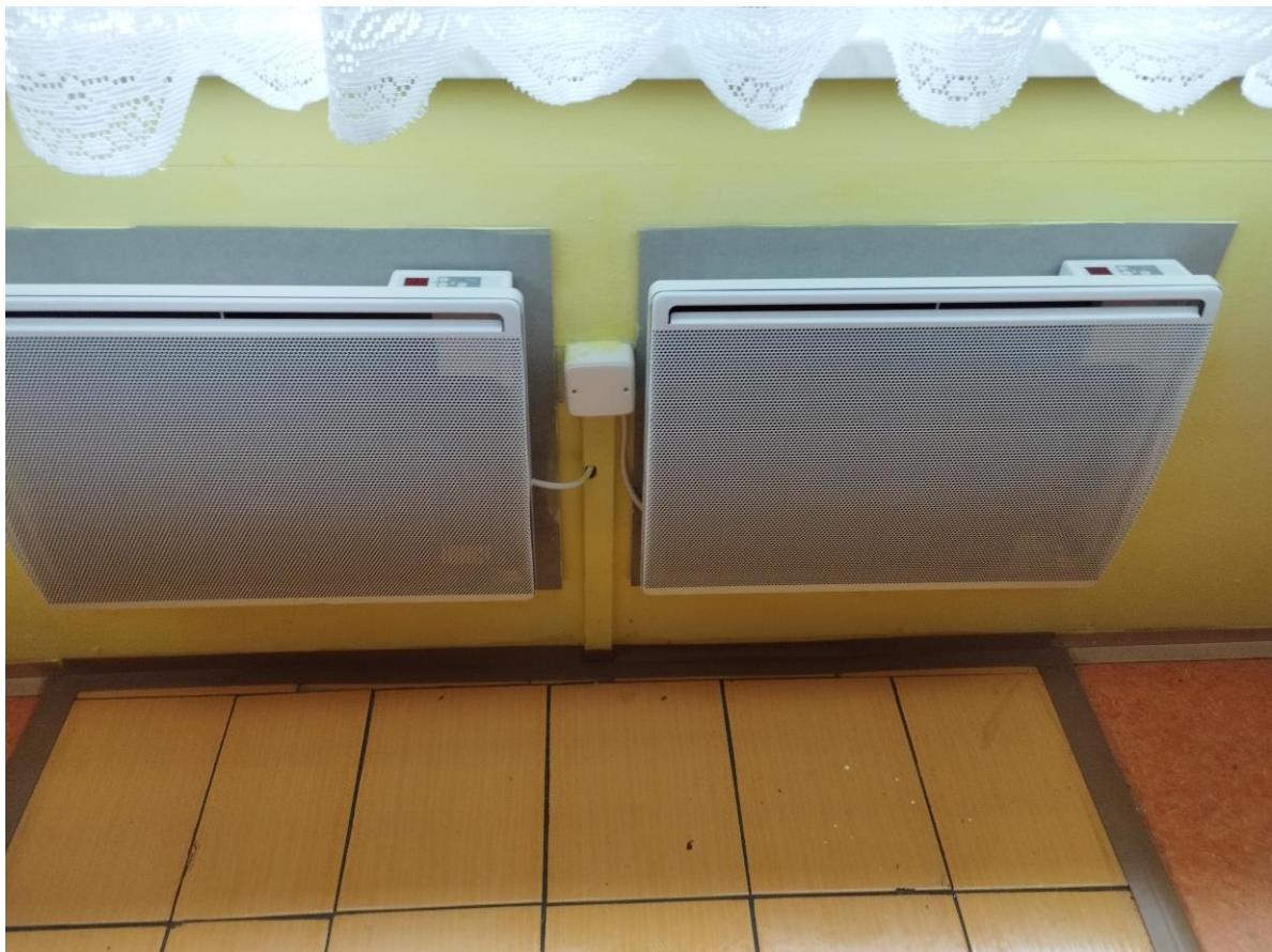
Přímotopy místo akumulčních kamen
